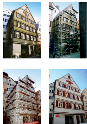
Fotoserie der Sanierungsarbeiten in der Kronenstraße 4, Fotografien Umweltzentrum Tübingen e.V., 2016.
